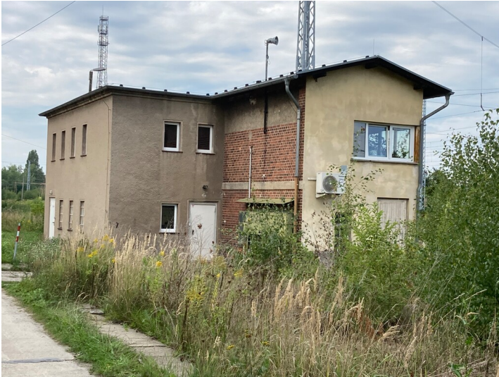
Stellwerke am Südwestkopf des Bahnhofes Fotograf/Urheber: Tom Pfefferkorn
