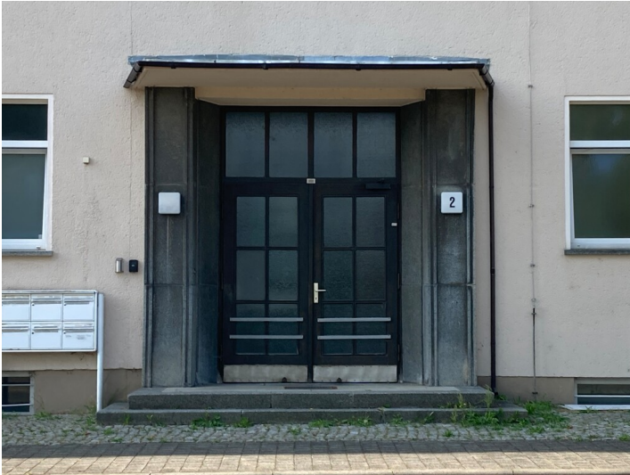
Verwaltungsgebäude am Bahnhofsvorplatz, Eingang, von Norden Fotograf/Urheber: Tom Pfefferkorn
