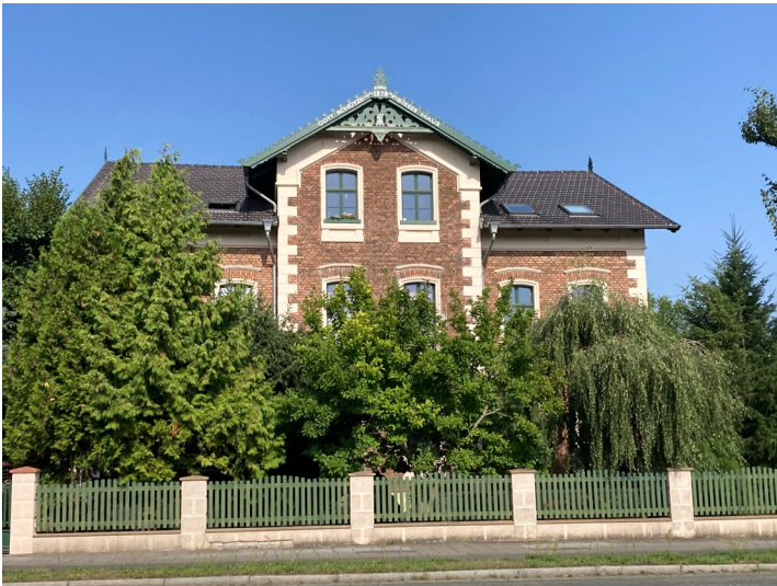
Ehemaliges Reichsbahn-Archiv, Ansicht von Südosten Fotograf/Urheber: Tom Pfefferkorn
