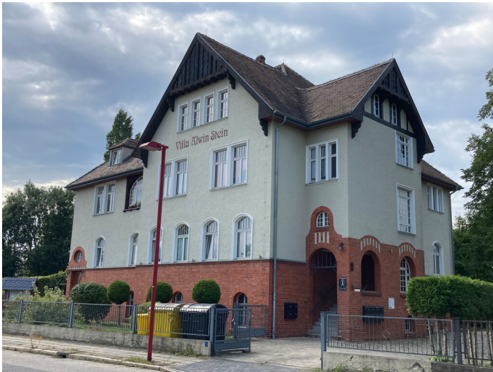
Kulturhaus der Eisenbahner "Alwin Stein", Ansicht von Nordosten Fotograf/Urheber: Tom Pfefferkorn
