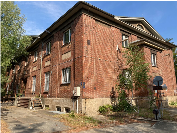
Werkstattgebäude, Ansicht von Südosten Fotograf/Urheber: Tom Pfefferkorn
