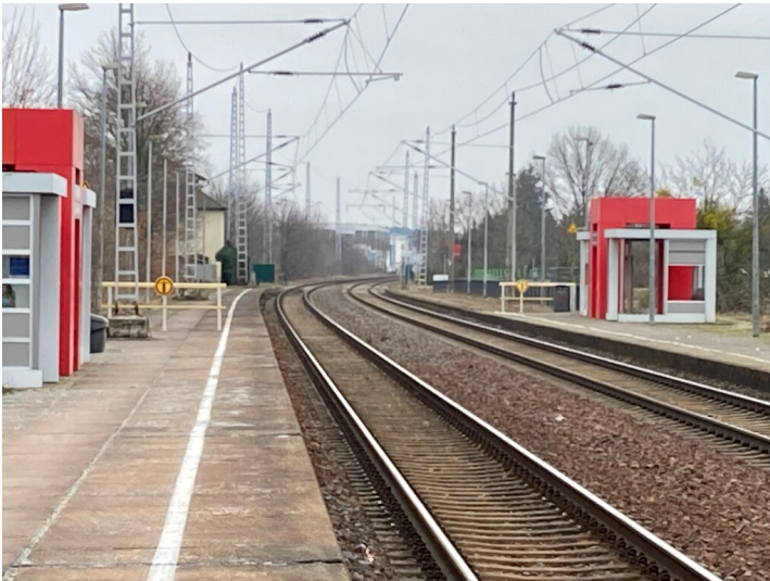
Haltepunkt Hoyerswerda Neustadt Wojerecy Nowe Mesto (BHWN) an der Strecke 6207 Ruhland-Wegliniec/Kohlfurt Fotograf/Urheber: Tom Pfefferkorn
