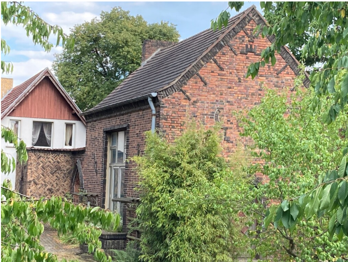
Ehemalige Ziegelei Gebrüder Weist, Ateliergebäude in einem gotisch inspirierten Art-déco-Stil mit künstlerisch gestalteten Ziegelfassaden, Ansicht von Nordwesten Fotograf/Urheber: Tom Pfefferkorn
