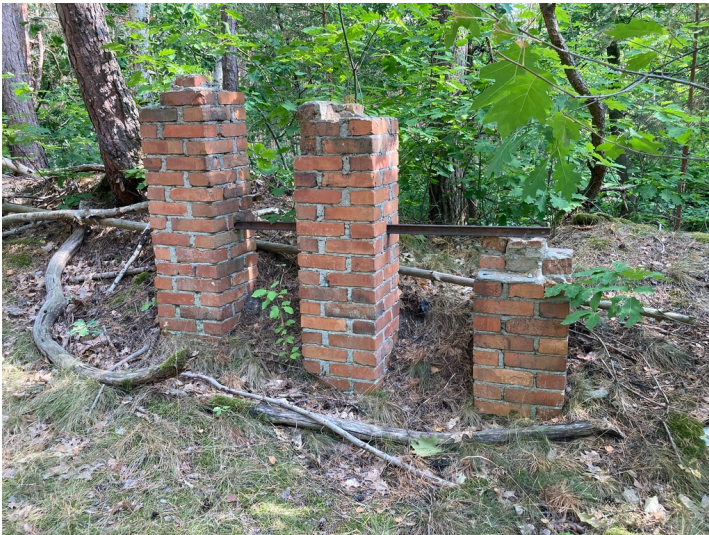
Ehemalige »Lorenzsche Ziegelei«, Relikte an der ehemaligen Bahntrasse zu den Tongruben Fotograf/Urheber: Tom Pfefferkorn
