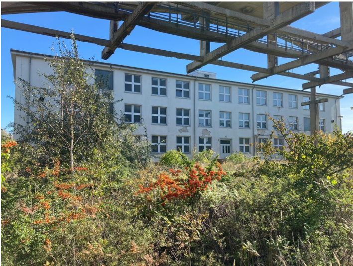
Ehemalige Kaue des Gaswerks Schwarze Pumpe, Ansicht von Nordwesten Fotograf/Urheber: Tom Pfefferkorn
