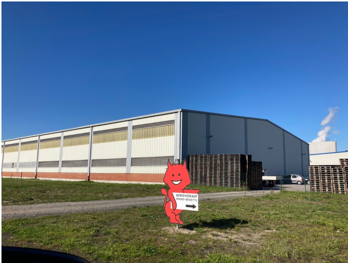
Brikettfabrik, Palettenlager 10 kg, von Südosten Fotograf/Urheber: Matin Neubacher
