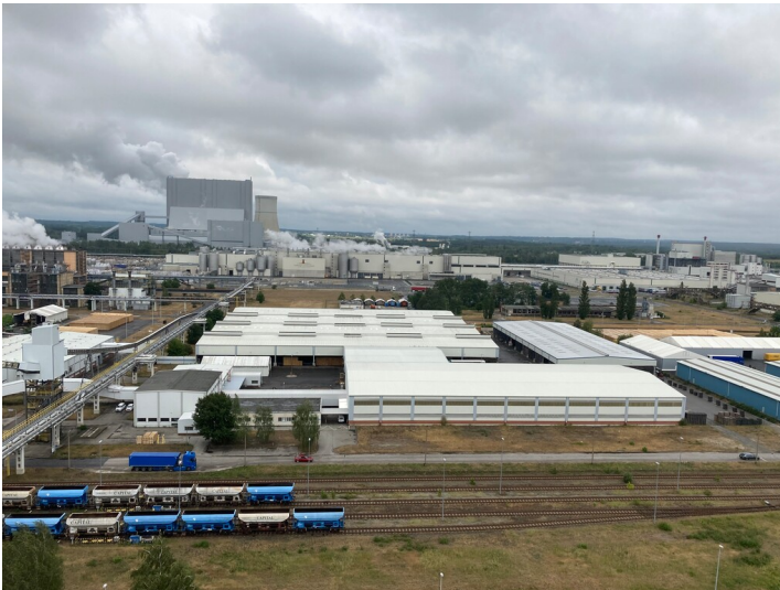
Brikettfabrik, Stapelhalle 25 kg-Paletten, von Süden gesehen Fotograf/Urheber: Nora Wiedemann
