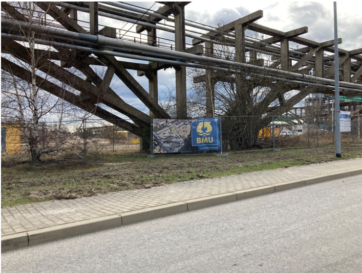
Medienbrücken aus Beton, ursprünglicher Bestand Fotograf/Urheber: Tom Pfefferkorn
