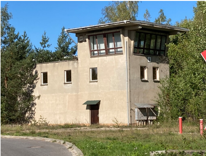
Stellwerk Nr. 4 der Werkbahn, Ansicht von Südwesten Fotograf/Urheber: Tom Pfefferkorn
