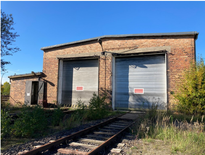
Lokschuppen der Werkbahn, Ansicht von Osten Fotograf/Urheber: Tom Pfefferkorn
