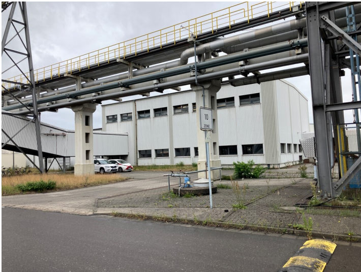
Palettierhalle 10 kg, von Südwesten gesehen Fotograf/Urheber: Martin Neubacher
