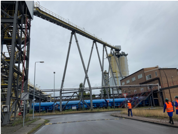
Brikettfabrik, Wirbelschichtbraunkohleverladung (derzeit außer Betrieb) Fotograf/Urheber: Nora Wiedemann
