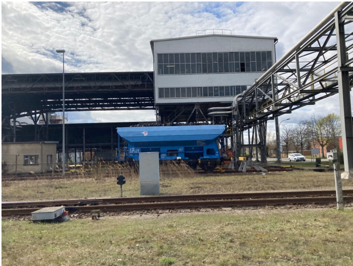
Brikettfabrik - ein Windenhaus links im Bild Fotograf/Urheber: Nora Wiedemann
