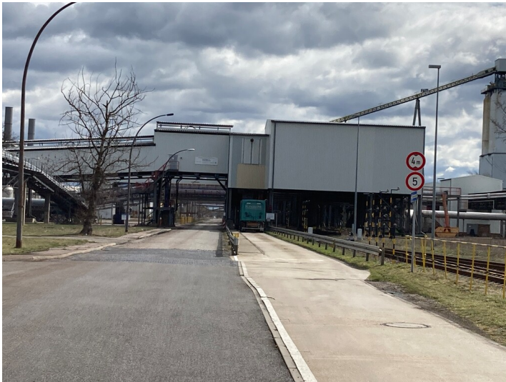
Landabsatzanlage Mitte, von Westen gesehen Fotograf/Urheber: Tom Pfefferkorn
