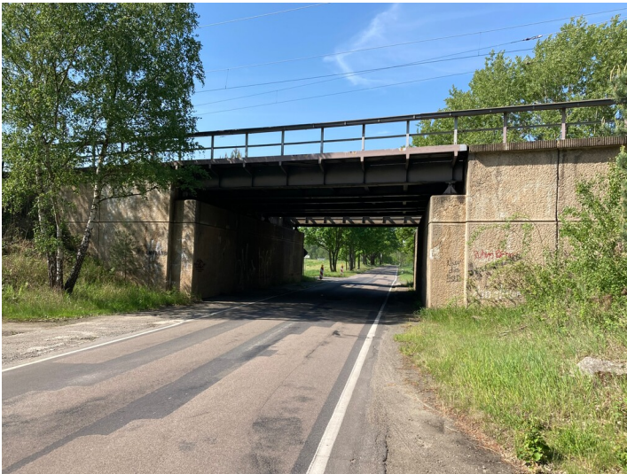
Mehrgleisige Eisenbahnbrücke mit Widerlagern aus Stahlbeton und Stahlüberbauten, Ansicht von Nordosten Fotograf/Urheber: Tom Pfefferkorn
