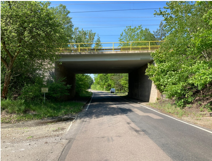
Mehrgleisige Bahnbrücke, Widerlager und Überbau als Stahlbetonkonstruktion, Ansicht von Nordosten Fotograf/Urheber: Tom Pfefferkorn
