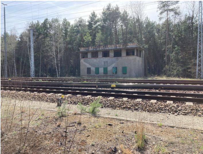
Güterbahnhof Spreewitz, außer Betrieb befindliches Stellwerk Fotograf/Urheber: Matin Neubacher
