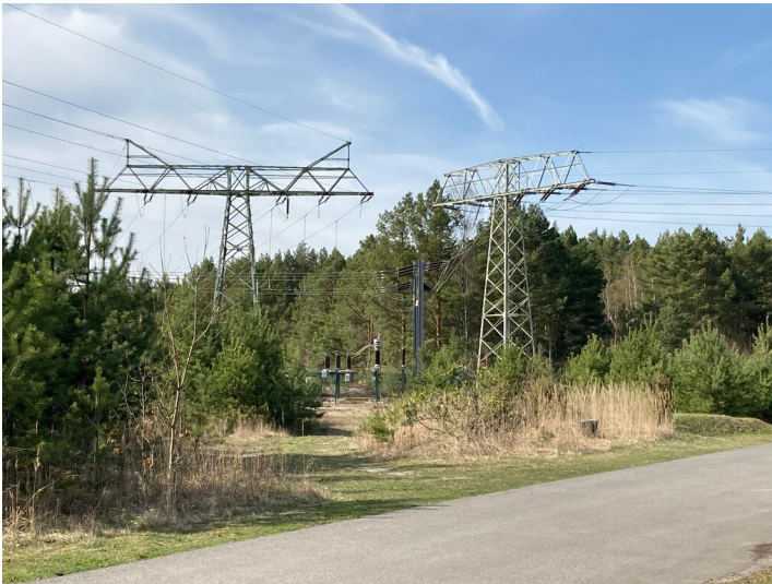
Umspannwerk, Teil der Regionalversorgung im 110 kV-Netz, regional- und industriegeschichtlich von Bedeutung Fotograf/Urheber: Anja Prust
