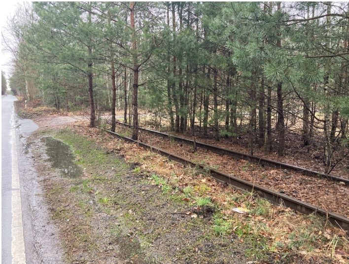
ehemaliger Bahnanschluss zum Komplexlager Fotograf/Urheber: Tom Pfefferkorn
