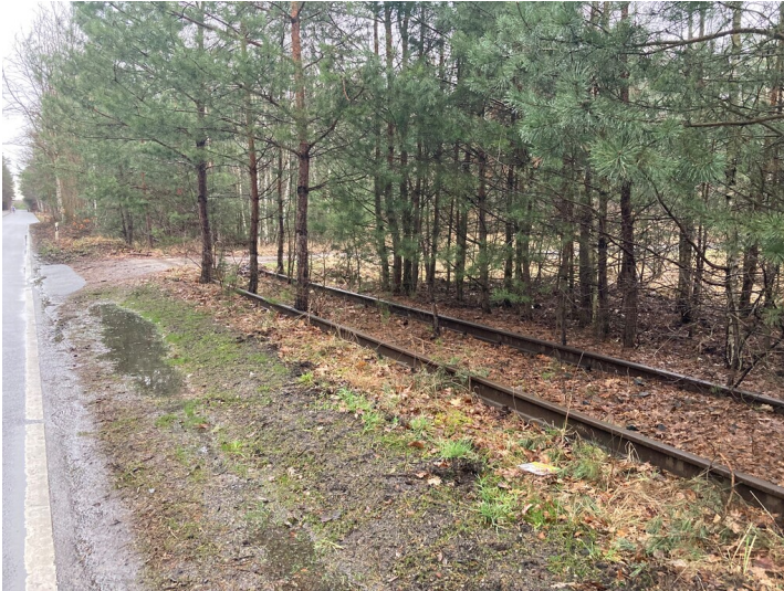
ehemaliger Bahnanschluss zum Komplexlager Fotograf/Urheber: Tom Pfefferkorn
