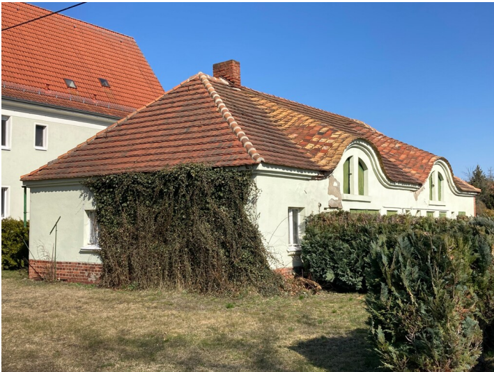
Kolonie Erika, Mehrfamilienwohnhaus Mittelstraße 8, Hofgebäude Fotograf/Urheber: Tom Pfefferkorn
