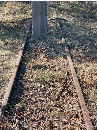
einzigster Gleisrest der 900 mm-Glassandbahn südlich der ehemaligen Grube Fotograf/Urheber: Tom Pfefferkorn
