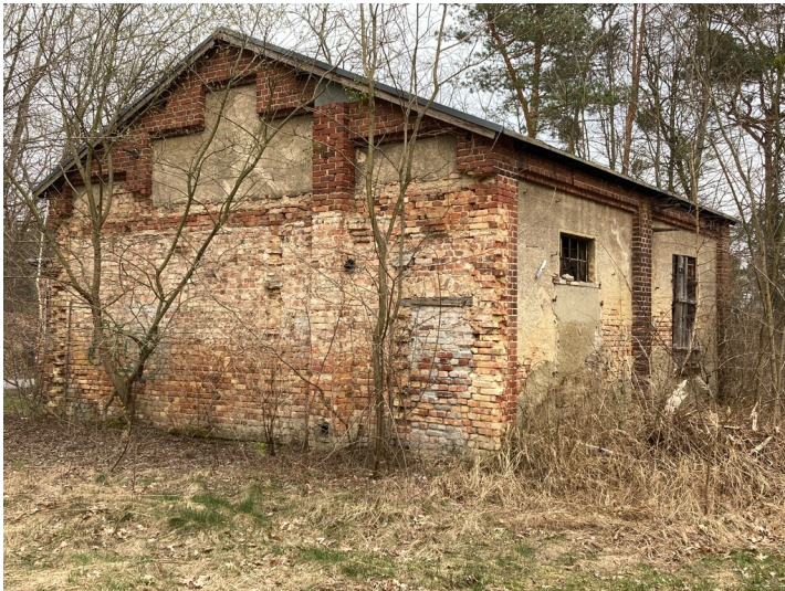
Maschinenhaus und Glassandgrube, heute "Tornoer Teich", Ansicht Maschinenhaus von Südwesten Fotograf/Urheber: Tom Pfefferkorn
