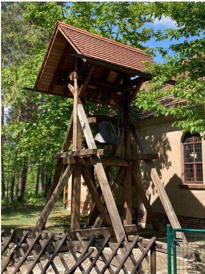
Evangelische Kirche Torno, einer der wenigen Kirchenneubauten der frühen DDR-Zeit, freistehender Glockenturm Fotograf/Urheber: Tom Pfefferkorn
