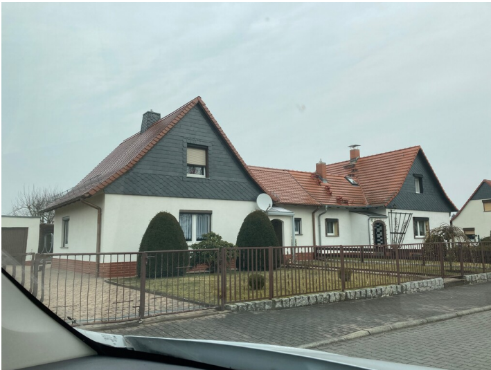
Wohnsiedlung vornehmlich aus etwa 180 Einfamilien- und Doppelwohnhäusern, in mehreren Bauabschnitten ab von Siedlungsgesellschaften des Lautawerkes 1938 bis 1943 errichtet Fotograf/Urheber: Nora Wiedemann
