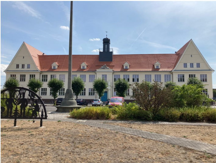
Das größte öffentliche Gebäude der Kolonie "Erika" Laubusch - die Schule. Ansicht vom Markt Fotograf/Urheber: Tom Pfefferkorn
