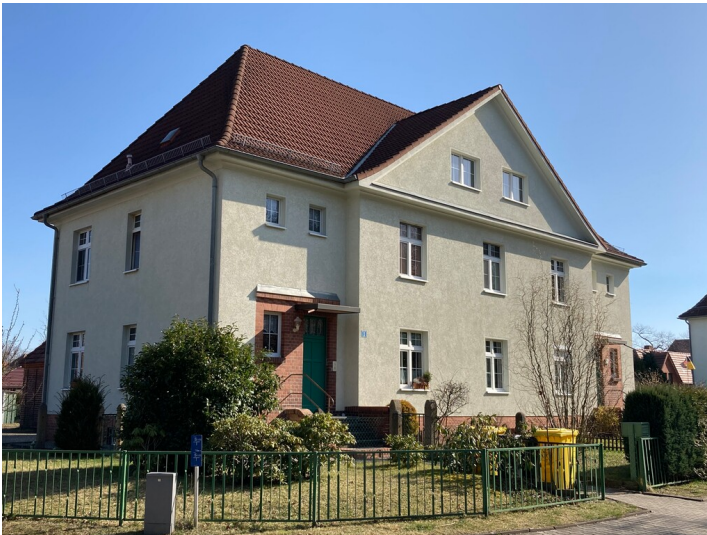
Kolonie Erika, 2 Mehrfamilienwohnhäuser Südstraße 1 und 2, von Westen gesehen Fotograf/Urheber: Tom Pfefferkorn
