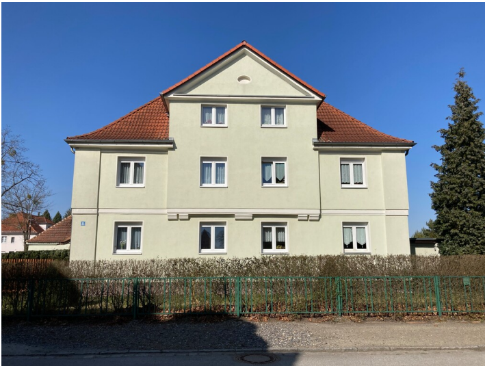
Kolonie Erika, Mehrfamilienwohnhaus Parkstraße 11, Ansicht von Osten Fotograf/Urheber: Tom Pfefferkorn
