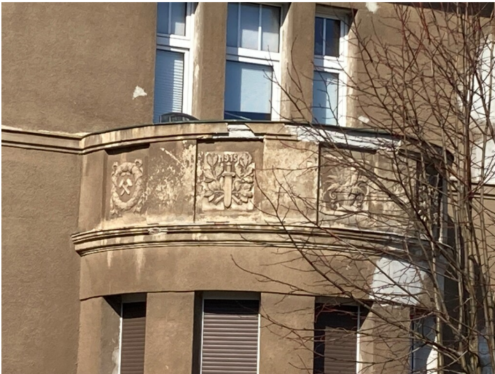
Kolonie Erika, ehem. Direktorenvilla Parkstraße 8, Bauzier Fotograf/Urheber: Tom Pfefferkorn
