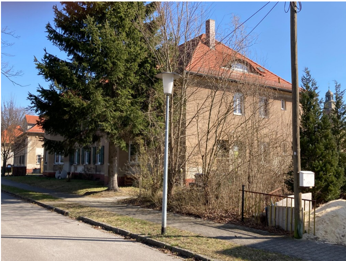
Kolonie Erika, Mehrfamilienwohnhaus Parkstraße 6, Ansicht von Südwesten Fotograf/Urheber: Tom Pfefferkorn
