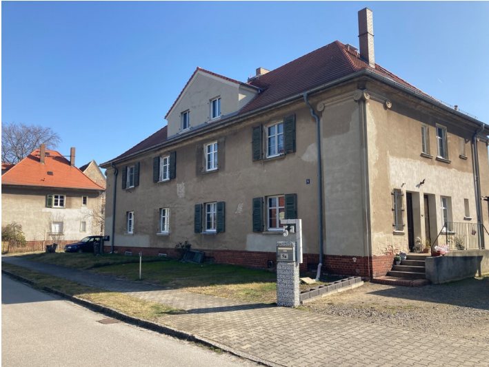
Kolonie Erika, Mehrfamilienwohnhaus Parkstraße 5 und 5a, von Westen gesehen Fotograf/Urheber: Matin Neubacher
