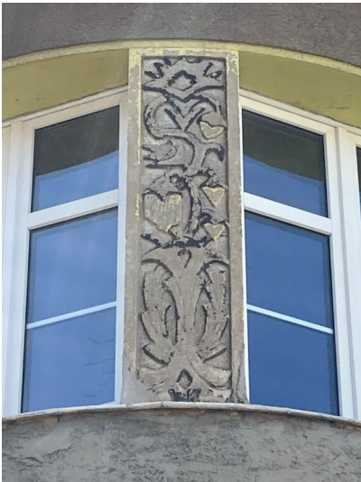
Kolonie Erika, Mehrfamilienwohnhaus Parkstraße 4, Erkerdetail Fotograf/Urheber: Tom Pfefferkorn
