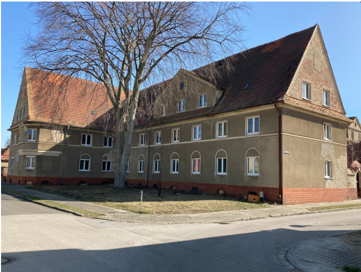
Kolonie Erika, Mehrfamilienwohnhaus Parkstraße 3, Ansicht von Südwesten Fotograf/Urheber: Tom Pfefferkorn
