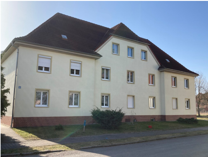
Kolonie Erika, Mehrfamilienwohnhaus Parkstraße 1, Ansicht von Nordwesten Fotograf/Urheber: Tom Pfefferkorn
