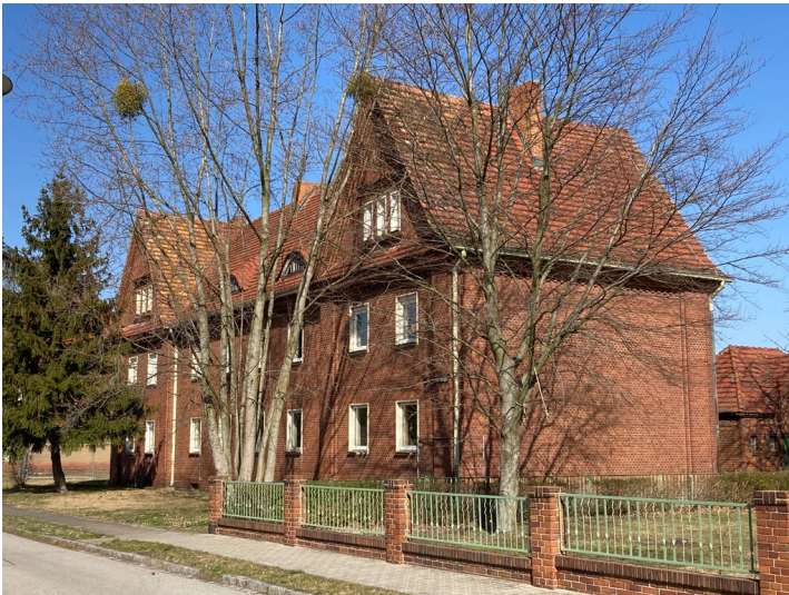
Kolonie Erika, Mehrfamilienwohnhaus Mittelstraße 6, Ansicht von Südosten Fotograf/Urheber: Tom Pfefferkorn
