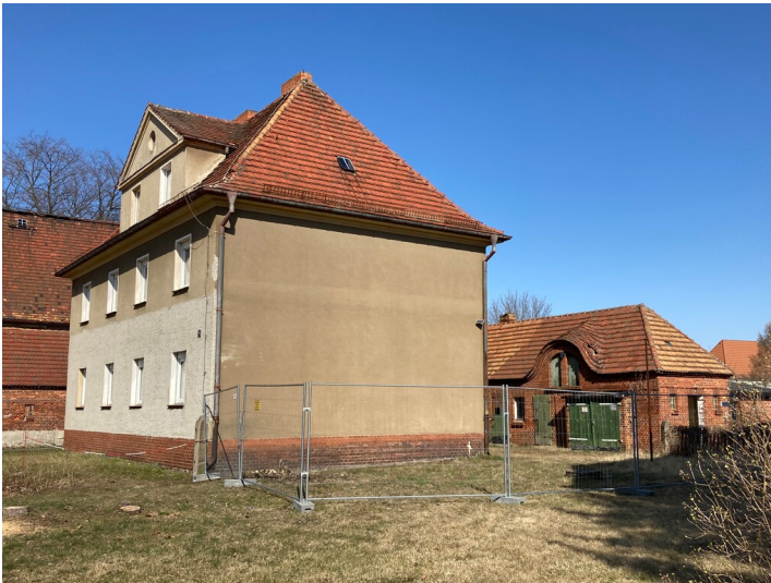
TKolonie Erika, Mehrfamilienwohnhaus Mittelstraße 5, Ansicht von Südosten Fotograf/Urheber: Tom Pfefferkorn
