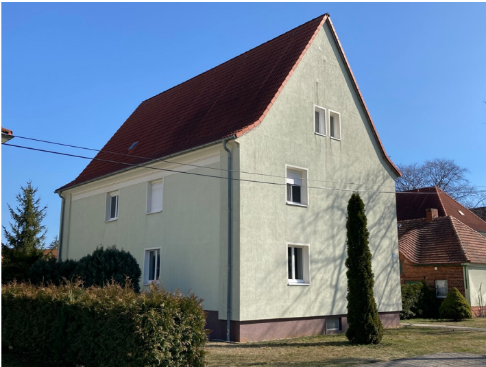
Kolonie Erika, 2 Mehrfamilienwohnhäuser Mittelstraße 2 und 4, Ansicht von Süden Fotograf/Urheber: Tom Pfefferkorn
