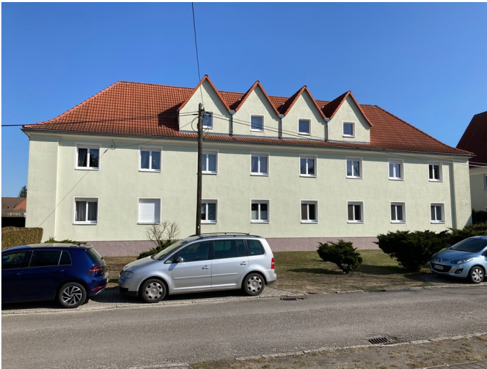
Kolonie Erika, Mehrfamilienwohnhaus Mittelstraße 3, Ansicht von Süden Fotograf/Urheber: Tom Pfefferkorn
