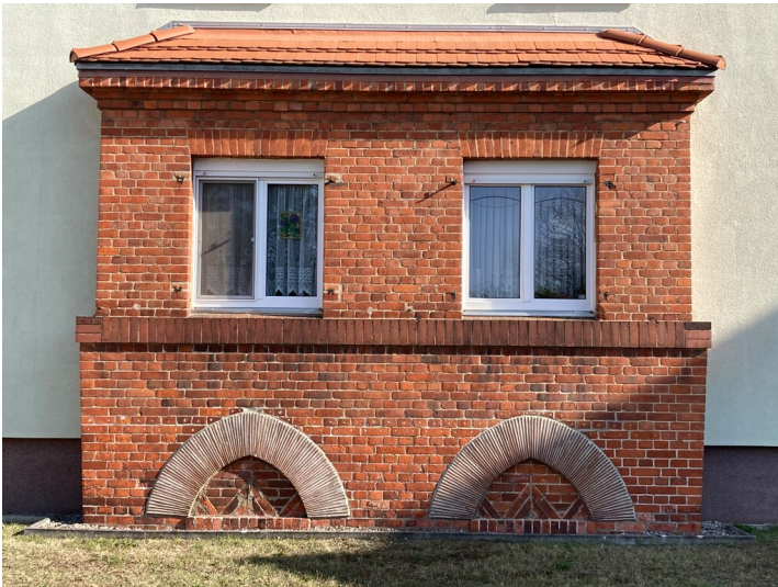
Kolonie Erika, Mehrfamilienwohnhaus Mittelstraße 1, Detail Fotograf/Urheber: Tom Pfefferkorn
