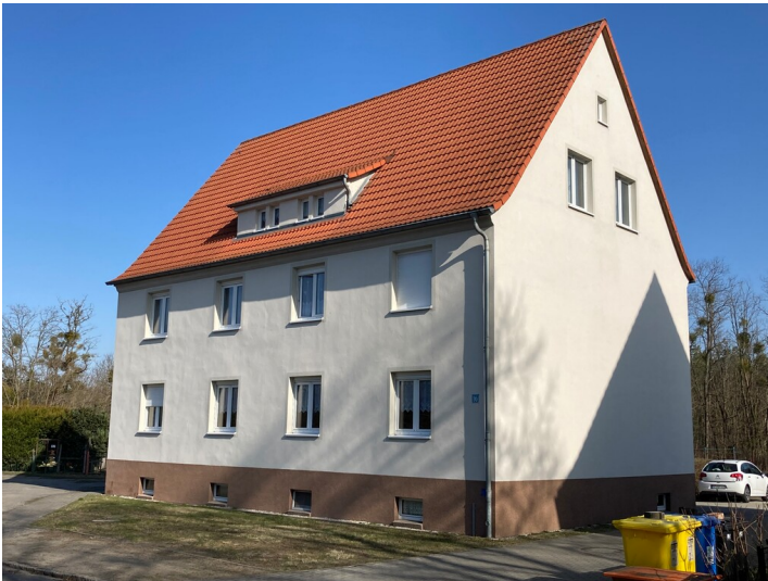
Kolonie Erika, 2 Mehrfamilienwohnhäuser Weststraße 11 und 16, von Süden Fotograf/Urheber: Tom Pfefferkorn
