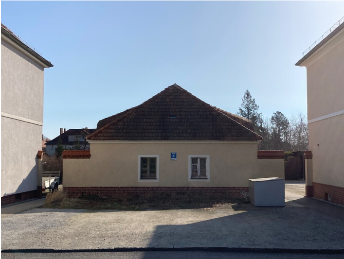
Kolonie Erika, Mehrfamilienwohnhäuser Weststraße 4/5, Hofgebäude für beide Häuser Fotograf/Urheber: Tom Pfefferkorn
