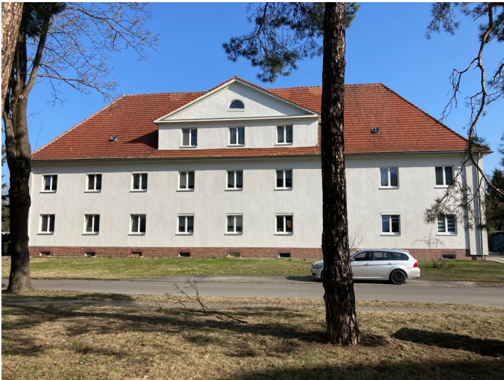
Kolonie Erika, Mehrfamilienwohnhaus Nordstraße 16, Ansicht von Süden Fotograf/Urheber: Tom Pfefferkorn
