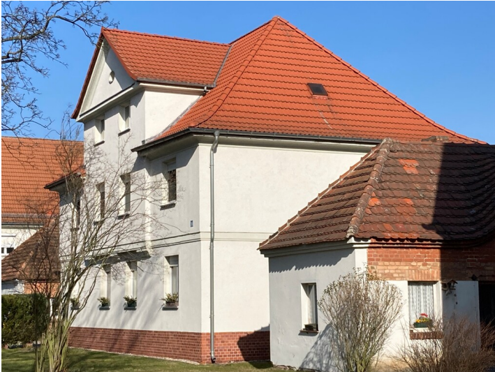
Kolonie Erika, 3 Mehrfamilienwohnhäuser Nordstraße 13, 14 und 15, von Südosten gesehen Fotograf/Urheber: Tom Pfefferkorn
