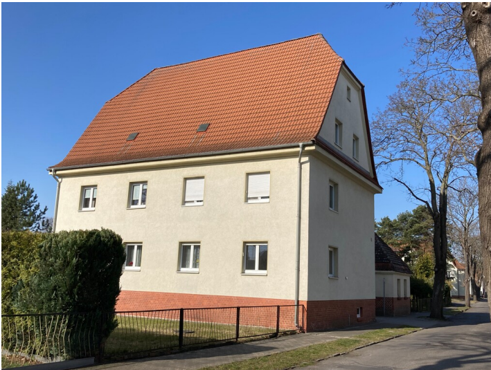
Kolonie Erika, Mehrfamilienwohnhaus Nordstraße 5, Ansicht von Osten Fotograf/Urheber: Tom Pfefferkorn
