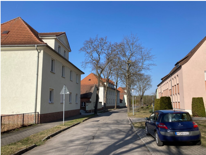
Kolonie Erika, Mehrfamilienwohnhaus Nordstraße 4, Blick Richtung Westen, Haus auf der linken Seite Fotograf/Urheber: Tom Pfefferkorn
