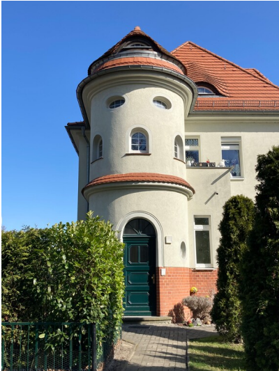
Kolonie Erika, Wohn- und Geschäftshaus Hauptstraße 13, Treppenturm Fotograf/Urheber: Tom Pfefferkorn
