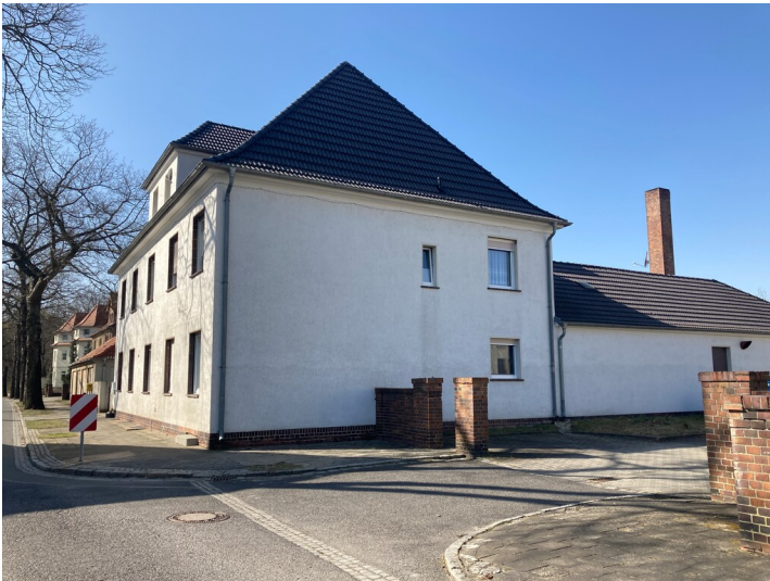
Kolonie Erika, 2 Wohn- und Geschäftshäuser Hauptstraße, Ansicht von Nordosten Fotograf/Urheber: Tom Pfefferkorn
